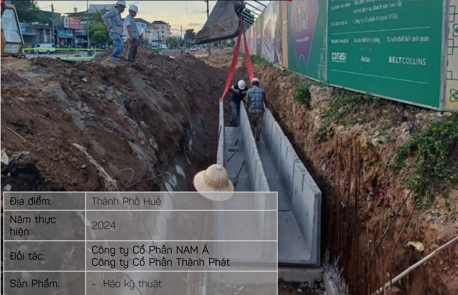
Cải tạo hệ thống thoát nước Thành phố HUẾ
